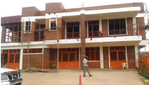
▲令和3年 完成間近の義肢製作所
